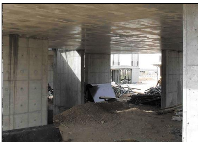
شکل ۱۲: باز کردن قالب ها
