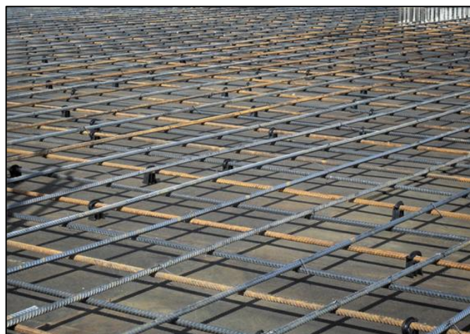
شکل ۷: بستن شبکه آرماتورهای پائین
