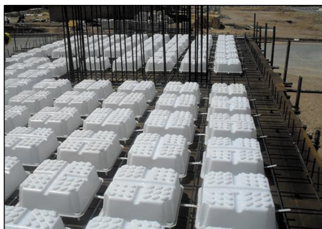
شکل ۸: چیدن قالب های U-Boot
