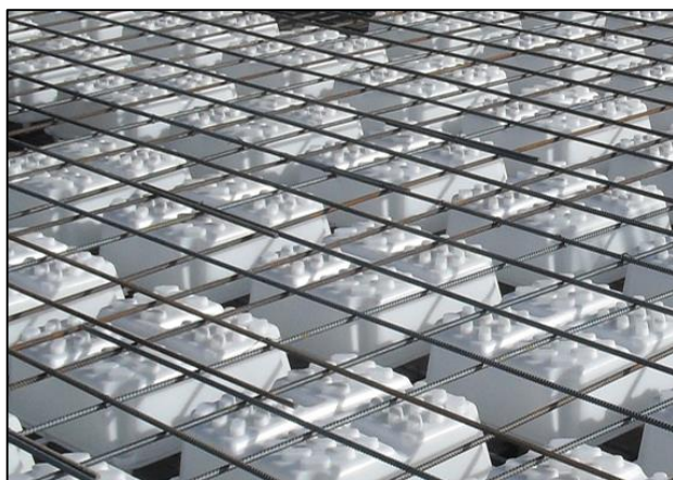
شکل ۹: بستن شبکه آرماتورهای فوقانی
