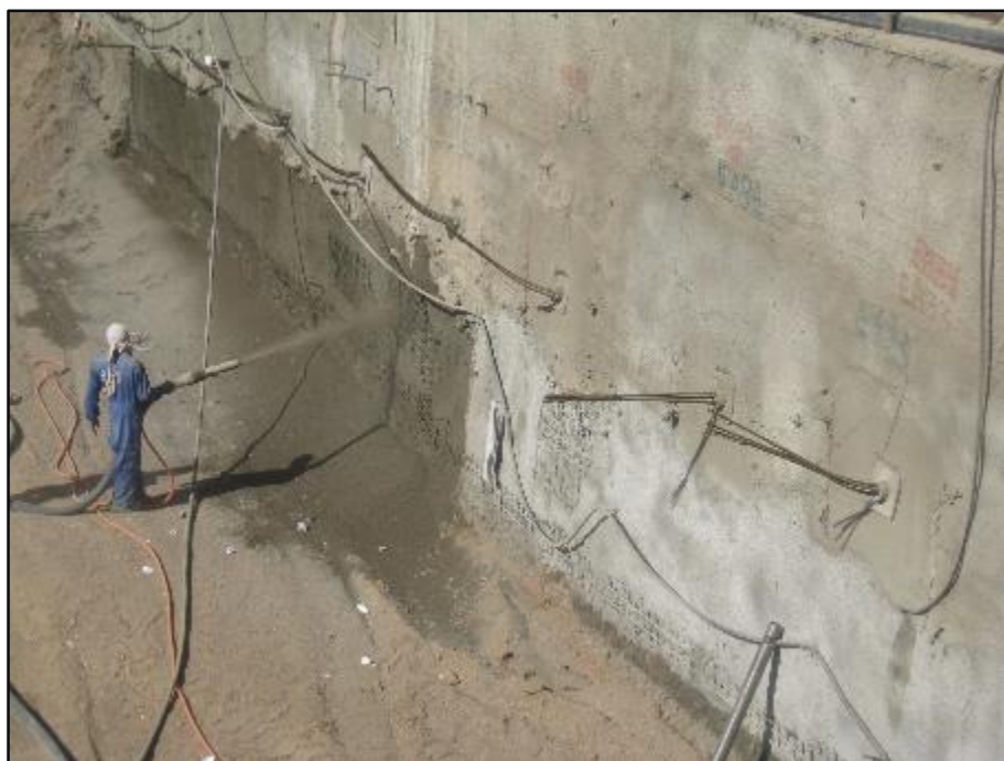
شکل ۷: اجرای لایه موقت مش و شاتکریت
