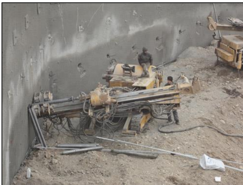
شکل ۵: دستگاه حفاری سوراخ میخ‌ها
